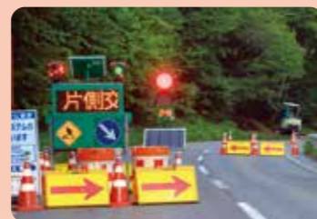
各種工事現場
